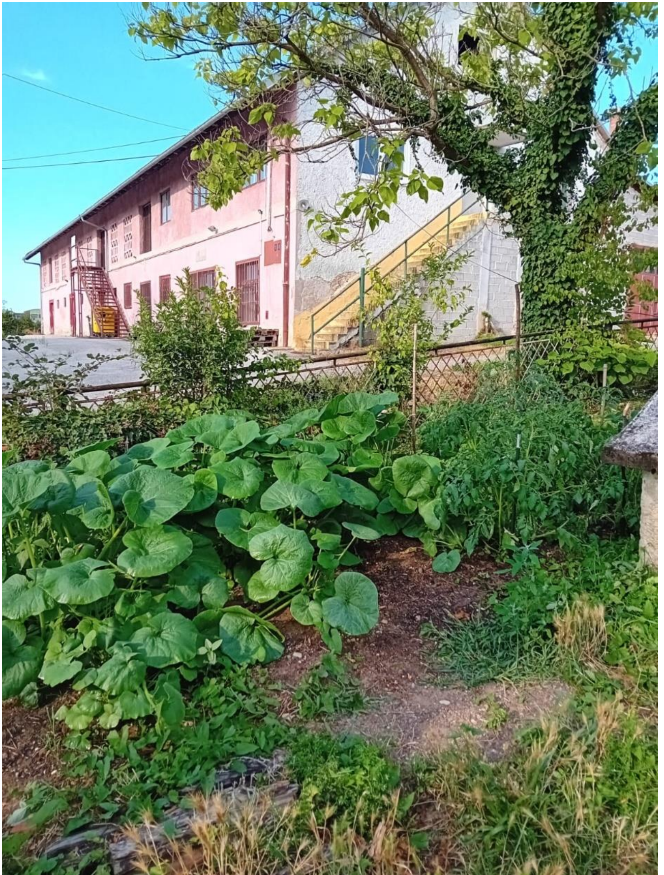
Vrt napreduje, a u pozadini se vidi Gospodarska zgrada , dio nekadašnjeg posjeda obitelji Holzinger...
